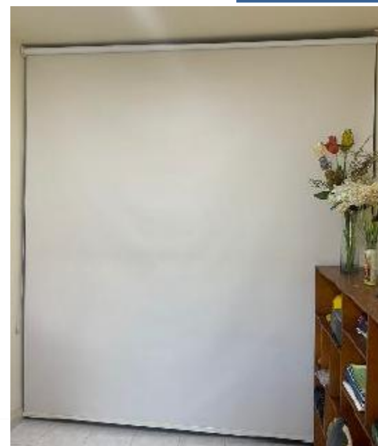
Instalación de Cortina Para Archivo
