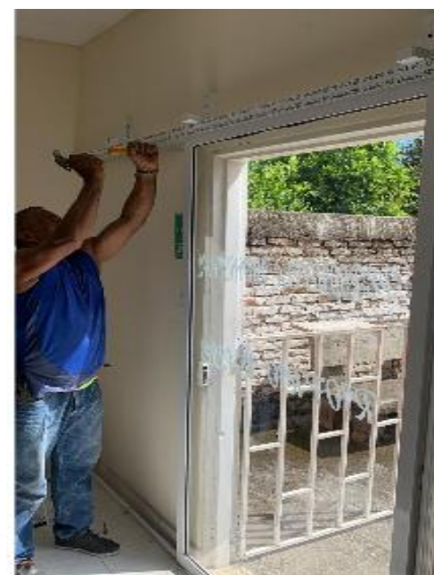
Instalación de Puerta Corrediza
