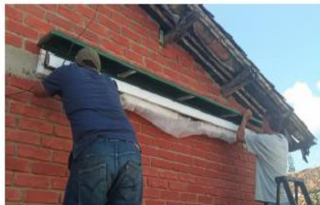
Instalación de Tolda Retráctil
